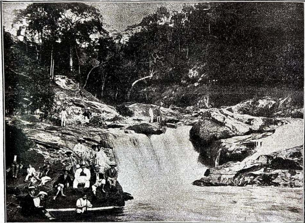
Cachoeira do rio Lourengo Velho, que serve á nova Usina de Electricidade da Companhia Industrial Sul-Mineira - Fôça de 3.200 cavallos
