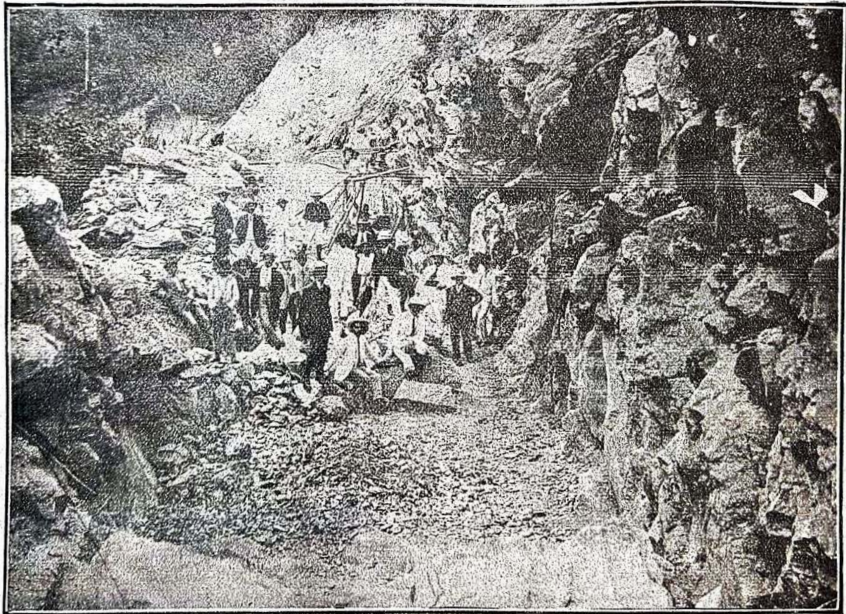
Usina electrica de Itajubá (Companhia Industrial Sul-Mineira) — Construção de um canal em rocha viva
