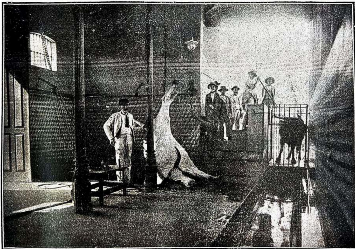
Cidade de Itajubá — Interior do Matadouro Municipal. Todo o serviço é executado sob a fiscalização do sr. Arlindo Vieira Goulart, administrador.
